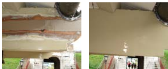
Dakgoot van Slot Loevestein hersteld met ITOX 2-componenten reparatiemassa.
