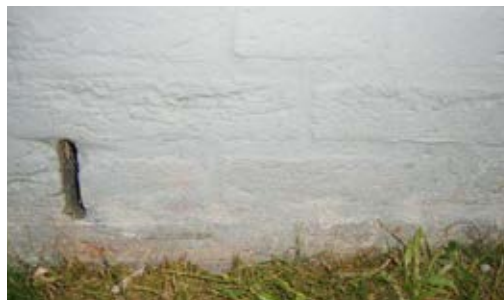
Muur na injectiewerk gereed voor nieuw keimwerk.
